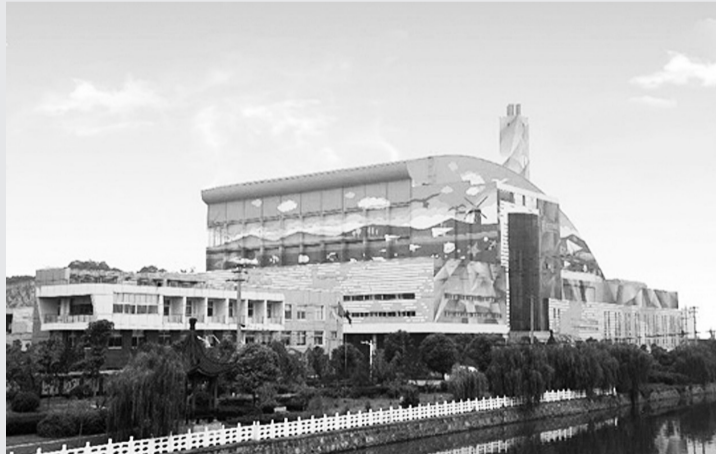
江阴市生活垃圾焚烧发电厂
