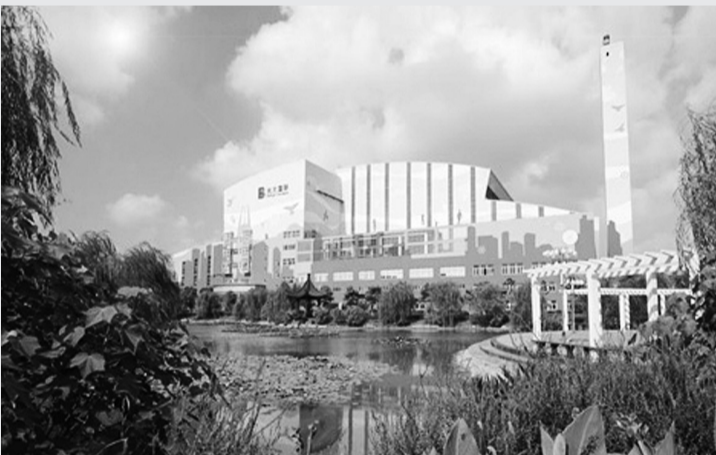
常州垃圾焚烧发电厂
