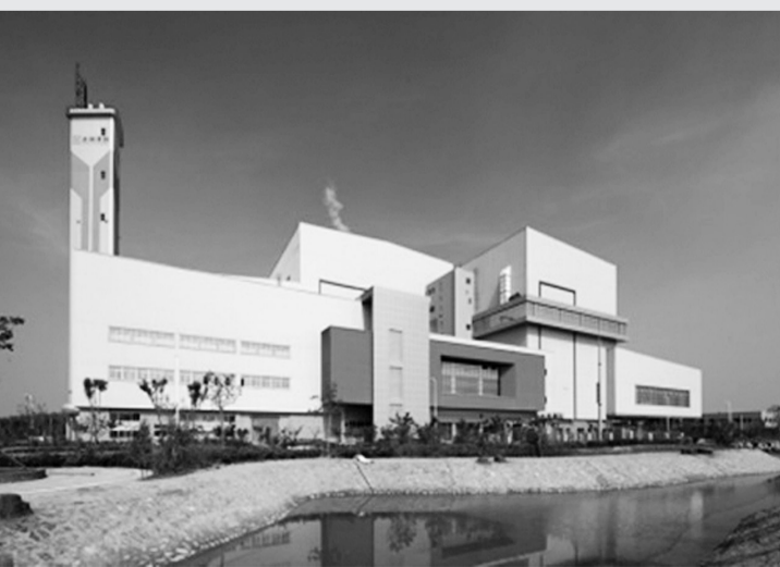
青岛小涧西城市生活垃圾焚烧厂
