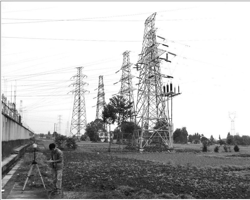
图为工作人员正在对变电站进行室外监测。 四川省辐射环境管理检测中心站供图
