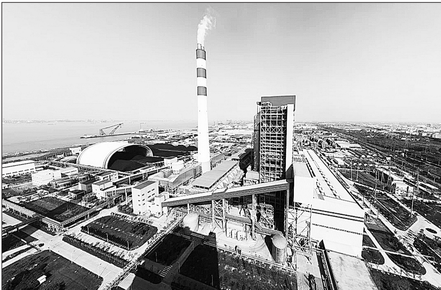
外三电厂至今保持供电煤耗最低的世界纪录,节约煤炭资源的同时,也大幅减少了污染物排放。图为外三电厂全景。资料图片
