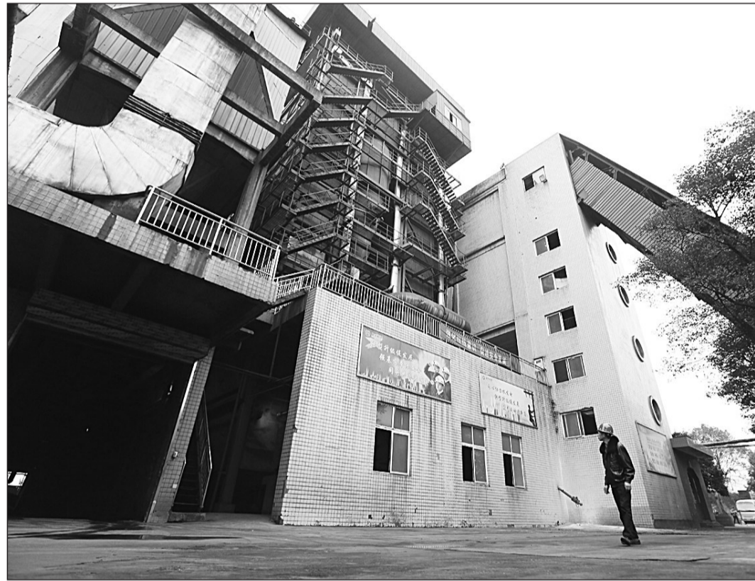
重庆市北碚区天府矿业公司磨心坡发电厂近日正式关闭。磨心坡发电厂属于小火电,是北碚区重点污染源企业,关停后每年将减少燃煤12.3万吨,削减二氧化硫2194吨、烟尘107吨、氮氧化物446吨,将极大改善重庆市主城区空气质量。图为一名工人从停产后的发电车间走过。
