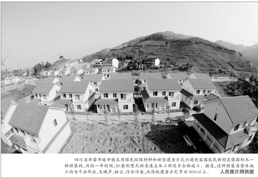
四川省华蓥市禄市镇采用绿色环保材料和新型建房方式兴建的梨园农民新村是像搭积木一样拼装的,历经一年时间,50套别墅式的房屋主体工程近日全面竣工。据悉,这种拼装房整体施工均为干法作业,无噪声、粉尘、污水污染,比传统建房方式节水90%以上。 人民图片网供图
