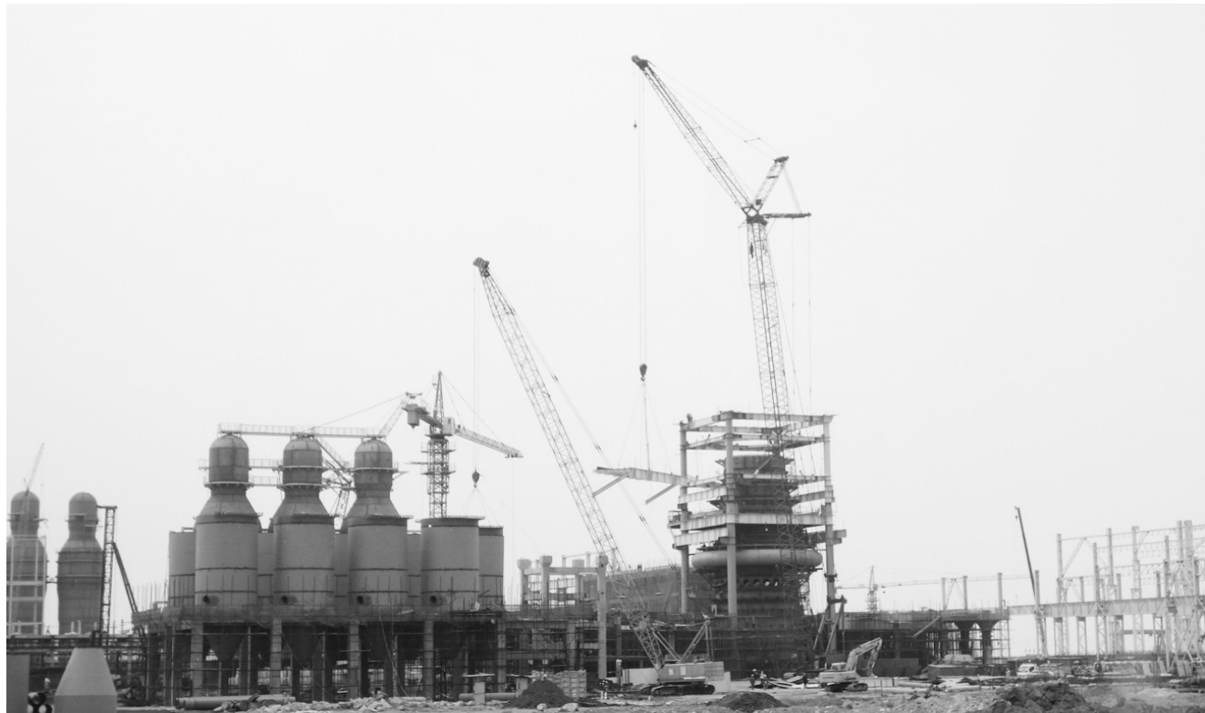
青岛钢铁集团将于2016年完成老厂关停、新厂投产,届时可实现年减排废水84.6万吨、二氧化碳940吨。图为青岛钢铁集团环保搬迁工程施工现场。中国日报图片网供图
