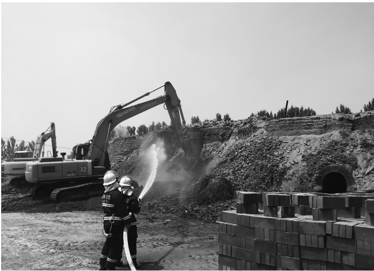
对河北省来说,钢铁、水泥、玻璃、电力等重污染行业仍面临巨大减排压力。图为一家被拆除的违法企业。周迎久供图
