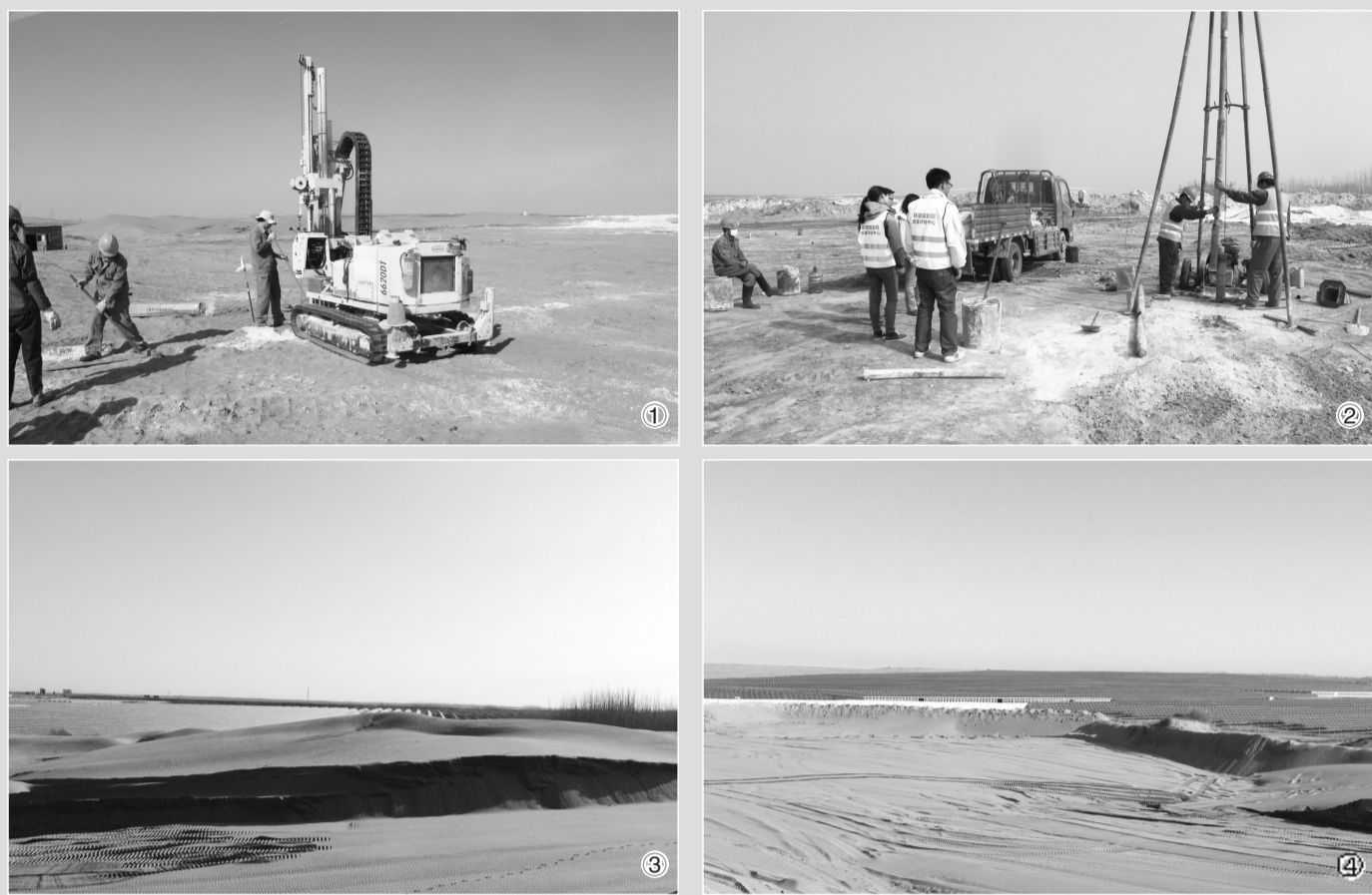
①某污染场地内,技术人员正在用直推式钻机GeoProbe采集无扰动的土壤样品。②使用钻机开展深层地层调查。③对污染场地内的渣土进行处理,以消除污染。④将渣土原位回填,并用黄土、黄沙覆盖,恢复污染场地地形地貌。
