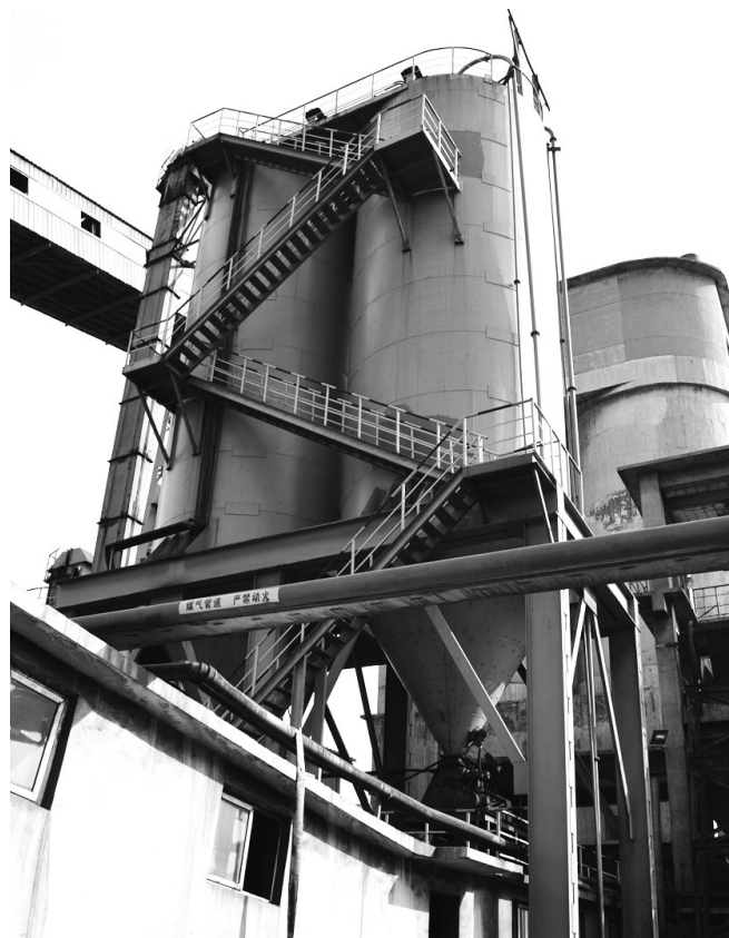
安徽临涣焦化公司引进吸排罐车把除尘灰运输到配煤系统,按比例配煤炼焦,去年累计回收除尘灰1.3万余吨,节约生产成本600余万元。 魏玉东摄
