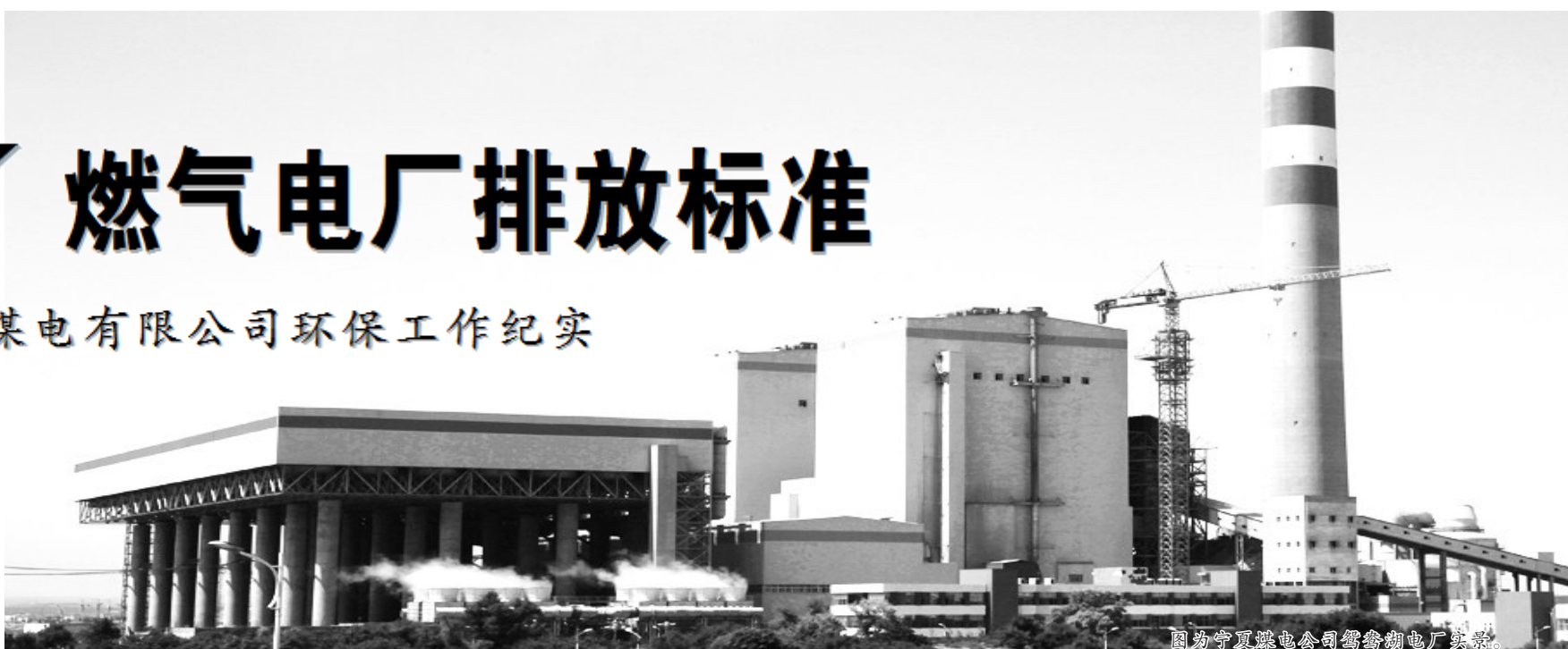
图为宁夏煤电公司鸳鸯湖电厂全景。
