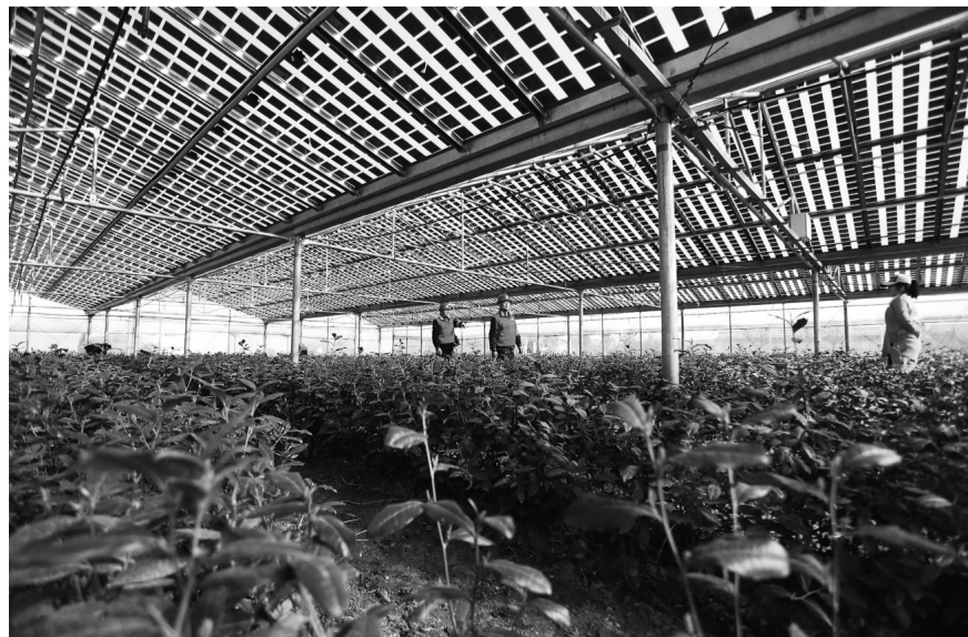
棚上发电、棚下种植的农光互补生态农业大棚在山东省即墨市初具规模。据当地供电公司统计,其年发电量达1150万千瓦时,并全部实现并网,年可节约标准煤3500吨。
