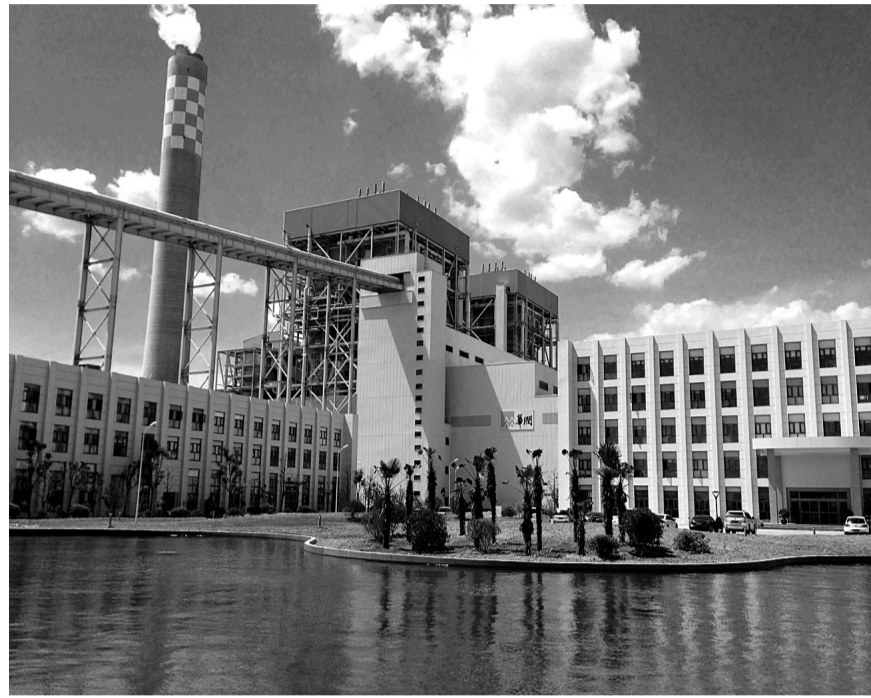
图为华润电力焦作龙源电厂全景
