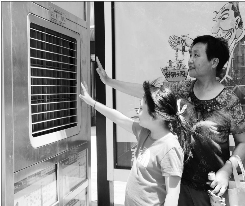
浙江省宁波市近日最高气温达到了39℃,几位乘客正在宁波慈溪市古塘街道范苑新村公交站候车时享用凉风。据悉,这一安装在站牌上的冷风机具有自动感应功能,乘客走到站牌旁,里面的机器就会自动运转,两三分钟内能降5~12℃。这个设备一天耗电量不超过三元钱。 人民图片网供图
