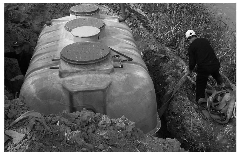
为稳步推进乡村连片治理,山东省桓台县起凤镇日前引进4台生活污水处理设备,这一设备能将生活污水直接转换成净水排入河中。图为工作人员正在安装设备。
