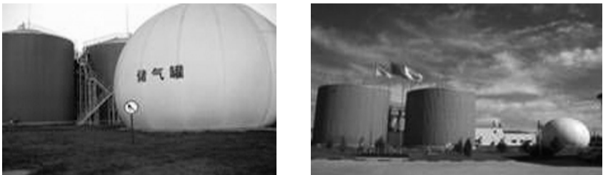
蒙牛乳业集团投资建设的大型沼气发电项目。
