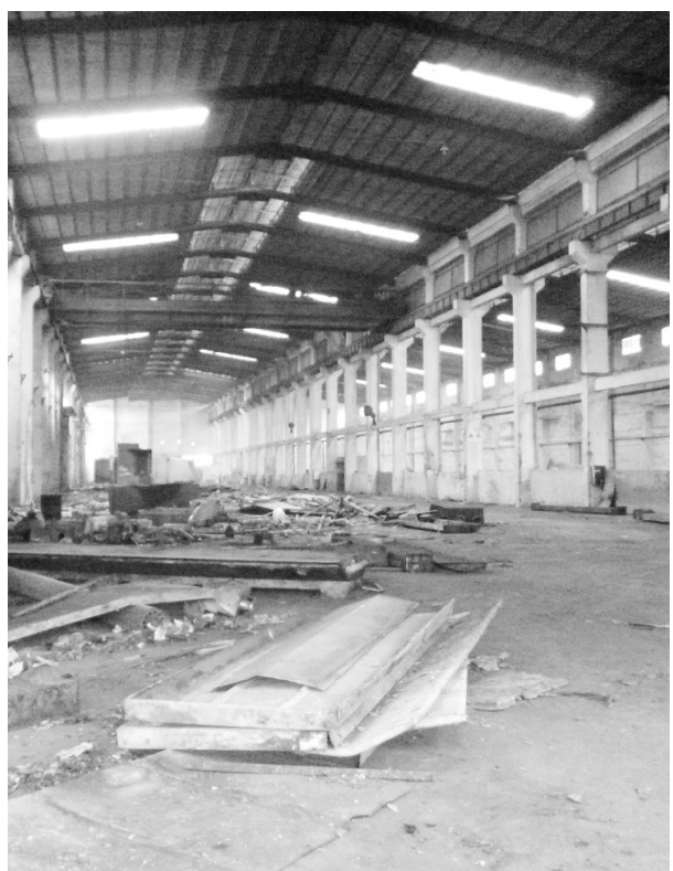
图为被拆除的纸机生产线。东莞宣教中心供图
