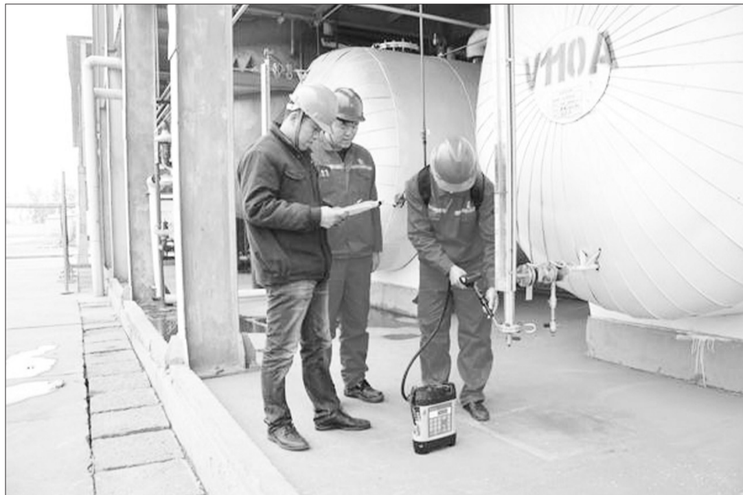
山东省淄博市淄川区积极引进LDAR泄漏检测与修复技术,对区内化工企业生产管线开展全面“体检”、精准治理,解决化工企业异味污染问题。图为第三方检测机构技术人员在淄川区广恒化工有限公司精馏釜液位计阀门连接处检测是否存在气体泄漏。王砚硕 董若义摄
