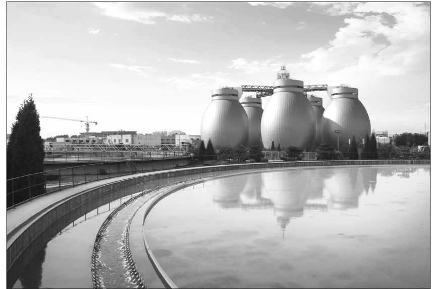
北京小红门60万吨/天再生水利用项目。项目拥有亚洲规模超前的曝气生物滤池,可有效去除水中BOD和氨氮,项目回水利用率高,处理水质可达四类水体质量标准。
