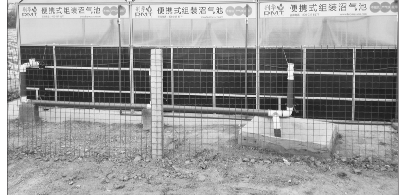
图为莒县建设的便携式组装沼气池。
