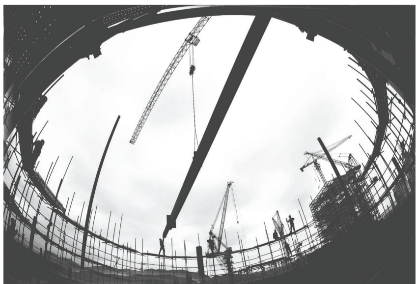
浙能温州发电厂7号机组正在安装超低排放吸收塔。
