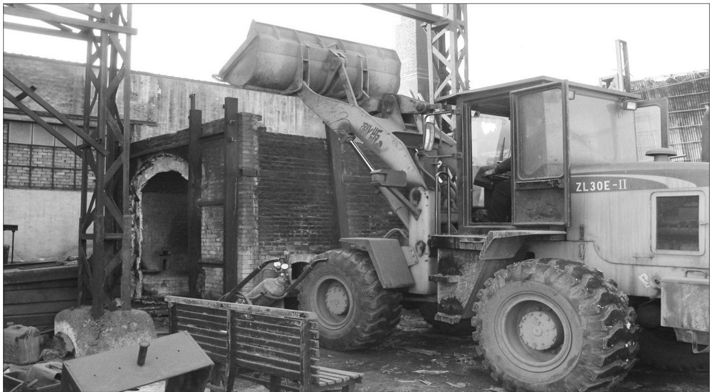
山东省章丘市开展铸锻行业燃煤污染整治行动,全市1091家铸锻企业限期拆除燃煤窑炉。图为恒升机械有限公司燃煤窑炉拆除现场。
