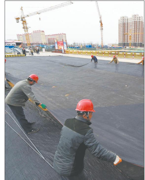
河北省大城县通过裸露土苫盖、围挡修建、垃圾清理、道路硬化、安装车辆自动冲洗及塔吊喷淋设施等措施,抑制建筑施工扬尘污染。图为2月27日,大城县一在建工地工人在进行裸露土苫盖。新华社供图
