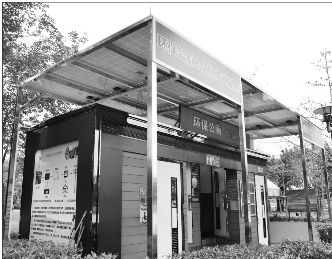
一座环保公厕近日在广东省广州市临江大道东驿站旁悄然亮相。据了解,公厕电源为屋顶太阳能电站,拥有4.7kW装机容量,年发电量为6860千瓦时左右。同时,因太阳能板有吸热、遮阳作用,盛夏的公厕室内温度可降低约5摄氏度。人民图片网供图
