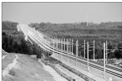
图为海南西环高铁昌江大岭一号特大桥,桥段采用桥梁方式通过,最大限度保护周边环境。 杨玉龙摄
