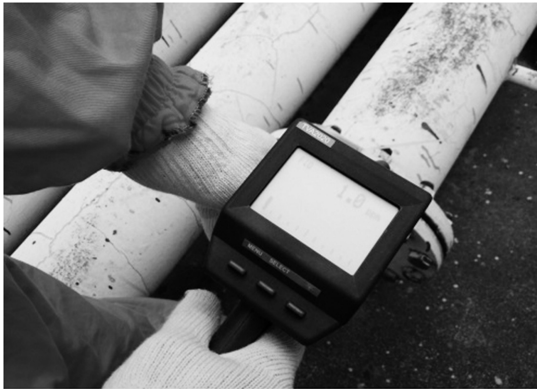
截至去年底,江苏已完成1559项VOCs污染整治重点工程,全省55家化工园区50%以上废气排放企业完成一轮整治,35家企业完成LDAR(泄漏检测与修复)技术改造。图为检测人员在检测管道接口VOCs泄漏情况。
