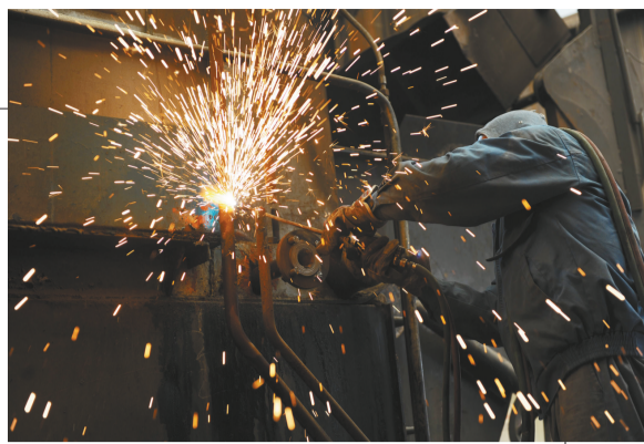
燃煤锅炉拆除
