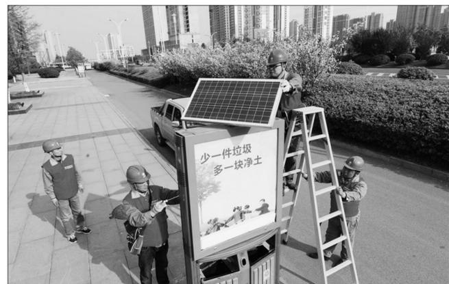
在安徽省滁州市南谯区东坡路,一批新安装的大太阳能垃圾箱近日亮相街头。据了解,垃圾箱顶部的太阳能板在充分接受日照的情况下,能够在夜晚支持垃圾箱内LED节能灯连续照明6个小时,提高了城区夜景亮化效果,方便了群众的夜间出行。 中国日报图片网供图
