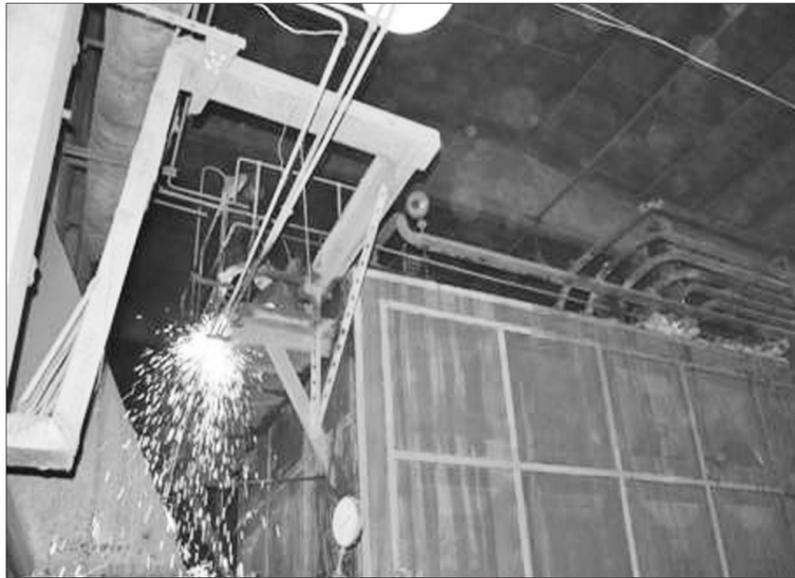
伴随着电焊切割绽放的火花,位于山东省济南市市中区回民小区内的两台供暖锅炉日前启动拆除。这是今年济南市淘汰的第一处供暖燃煤锅炉。两台锅炉拆除后,取代的是两台 8 兆瓦的电蓄热锅炉。 董若义 傅萍摄
