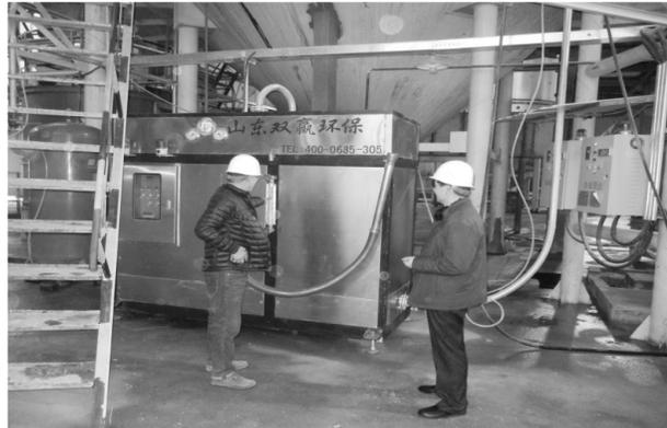
图为安装在淄博远丰建陶有限公司的脱硝装置。
