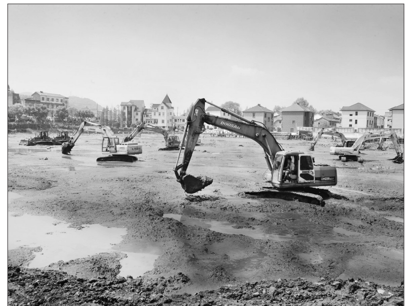
今年,浙江省诸暨市将对浦阳江流域实施清淤,明确落实清源头、疏干流、通支渠、秀村庄四大清淤攻坚任务。截至目前,全市27个乡镇(街道)已全面开展清淤工作,累计已完成清淤110万立方米,将于10月底完成清淤240万立方米的年度计划。 徐德文 朱晔晖/人民图片网供图
