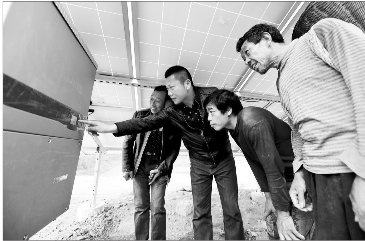
湖北省南漳县首个村级光伏发电项目近日在长坪镇陡山村并网发电。光伏电站建成并网后,带动绿色经济发展,每年至少可给村集体增加5万元以上收入。 人民图片网供图
