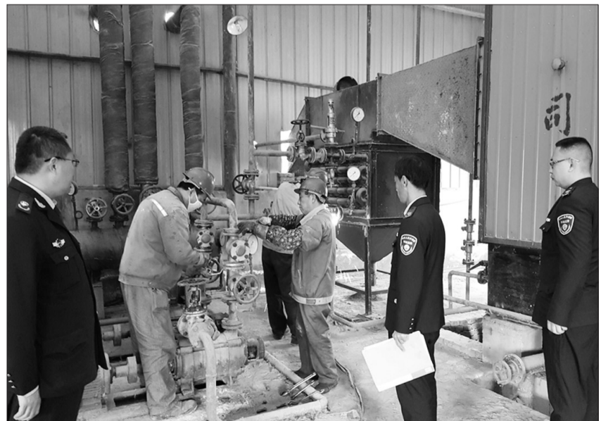
山东省临邑县以大气污染防治为重点,加快清理整顿燃煤锅炉工作进度,重点督导热力管网覆盖范围内10吨以下的燃煤蒸汽锅炉按照时限要求淘汰、关停。 图为临邑县环保局执法人员对企业的燃煤锅炉进行督导拆除。 桑志朋 王春涛摄
