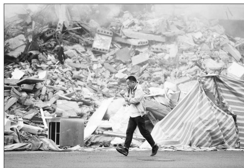
杭州市江城路菜场房屋拆除现场,由于近日施工队没有采取喷水抑尘等措施,导致工地尘土飞扬,路过的市民不得不掩鼻而过。 人民图片网供图
