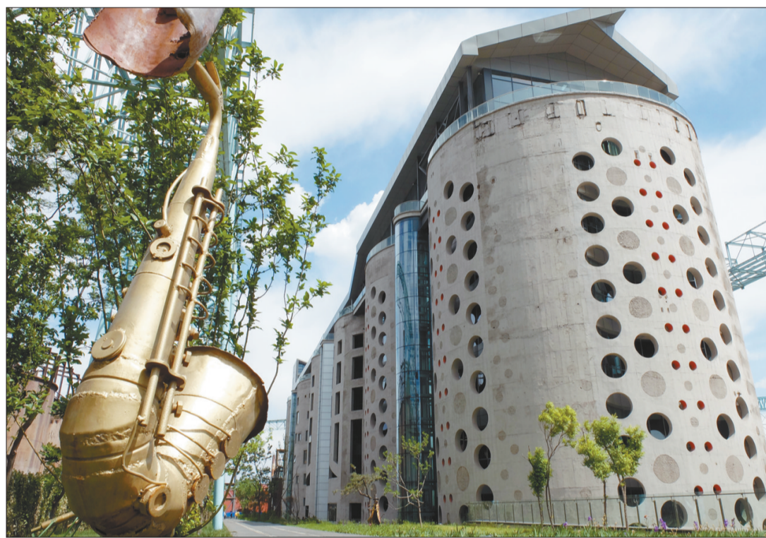
北京冬奥组委办公地日前在新首钢高端产业综合服务区首次向媒体开放。首钢原用于存放铁矿石的16个圆柱形筒仓和两个料仓,经过改造成为紧凑实用、功能齐全的办公楼,既体现了节俭的要求,也符合奥林匹克文化追求。 本报记者邓佳摄
