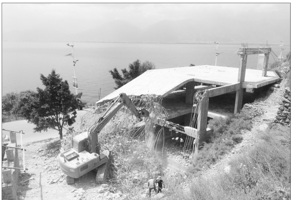
云南省大理州牢固树立“洱海清、大理兴”的理念,划定洱海生态红线,从严执法。图为大理州多部门联合在双廊镇开展环境综合整治,对临洱海的10座未批先建违法建筑依法进行强制拆除,拆除总面积为5020.84平方米。 张月生 廖莉摄
