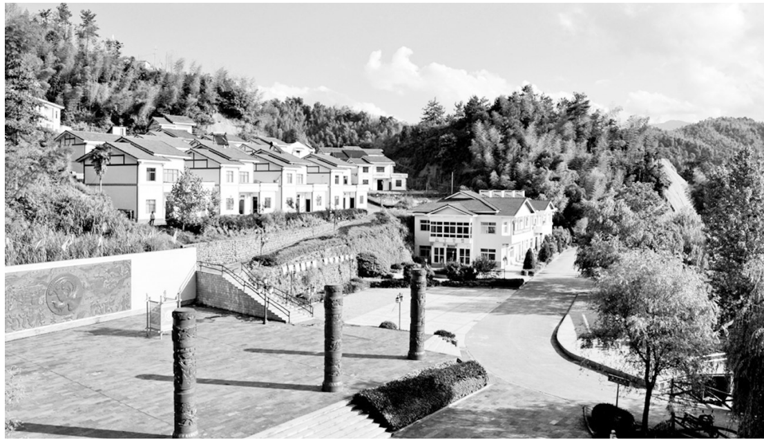
近年来,江西省贵溪市不断加快落后产能淘汰步伐,加大环境保护力度,努力打造净水、净空、净土的生态环境。 图为国家级生态村贵溪市樟坪村。 刘永华摄
