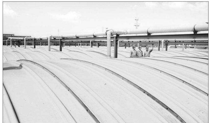
投资近1亿元建成的30000平方米污水池加盖和生化处理设施,规模居全球前列。
