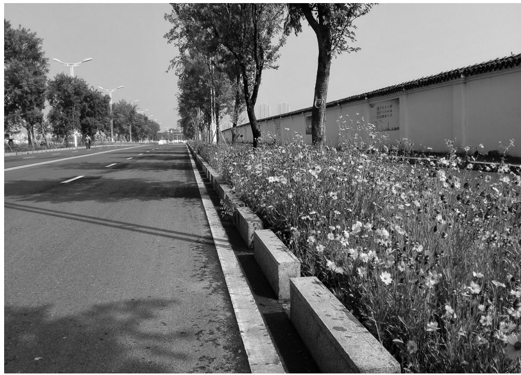
镇江金山湖路路边的植草沟。初期雨水可通过路牙豁口流入植草沟,通过介质土下渗过滤,消除面源污染。张蕊摄
