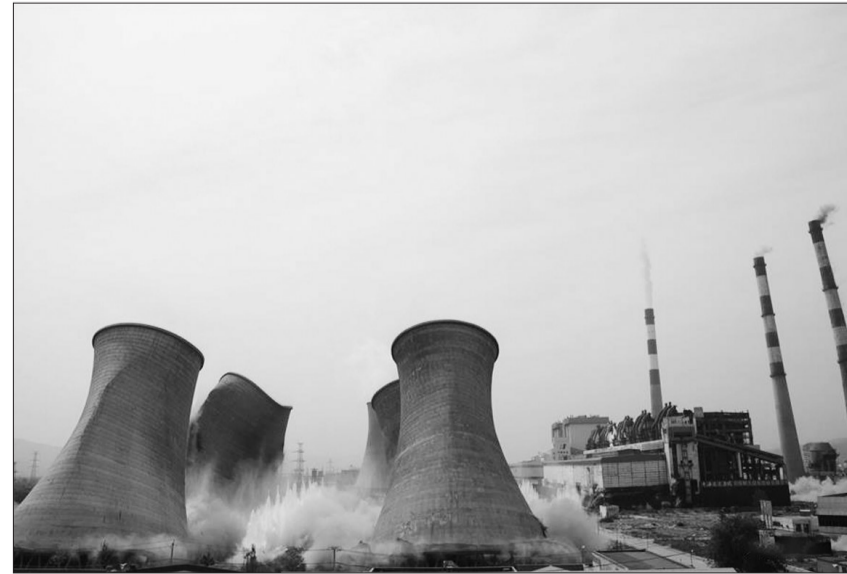
青海省西宁市一座总体面积达14万平方米的发电厂因达不到国家环保指标和节能减排要求,于近日被整体爆破成功拆除。 中国日报图片网供图
