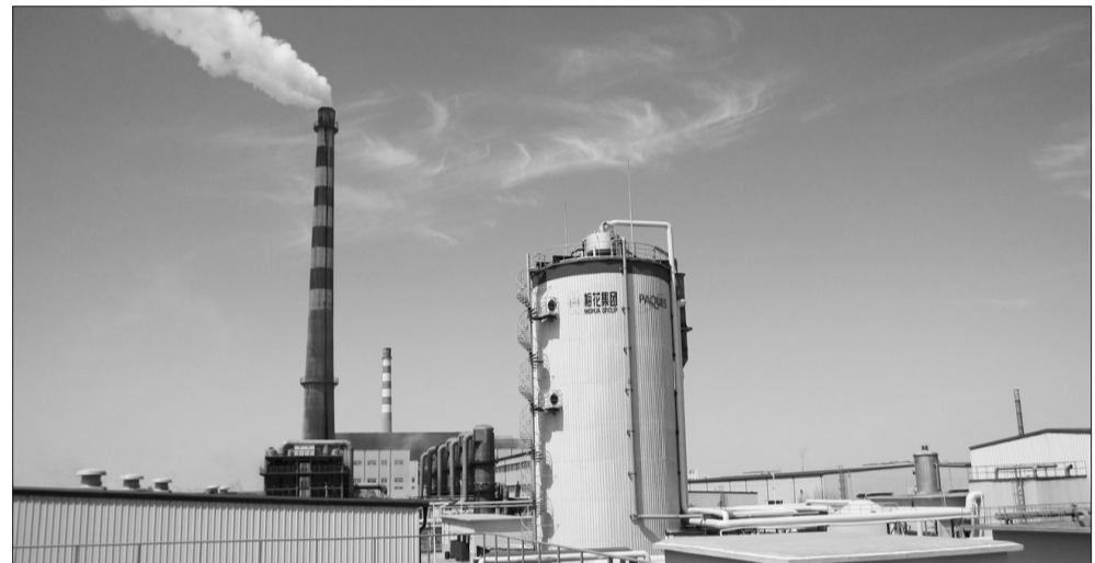
图为梅花生物科技有限公司正在运行的工程项目。
