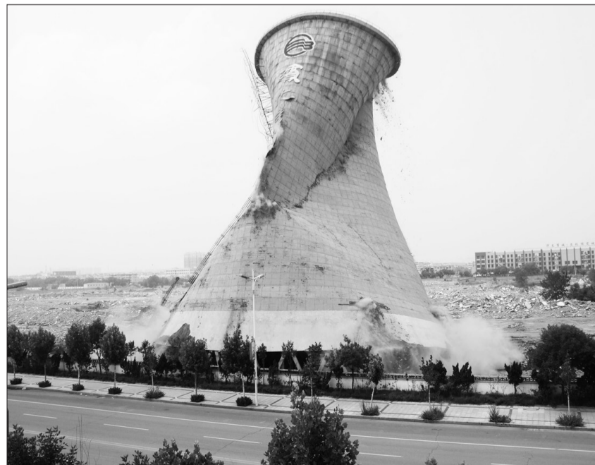
山东省滨州市一化工企业老厂区搬迁后最后一座高达 58 米的巨型冷却塔近日成功拆除。公安、环保、交通、安全、企业等部门相关人员严阵以待,对现场进行管控。事后,消防车对现场进行喷水降尘,环保措施到位,基本未对周围居民造成影响。
