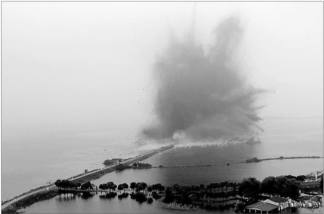
湖北省梁子湖与牛山湖隔堤近日正式破坝分洪。据湖北水利专家论证,破坝分洪后,两湖变一湖,原来的牛山湖可以承担梁子湖 5000 万立方米水量。专家认为,此举不仅可达到为梁子湖分洪的目的,湖水面积扩大还将有利于梁子湖减少养殖污染,增强湖泊自净功能,实现生态修复。
