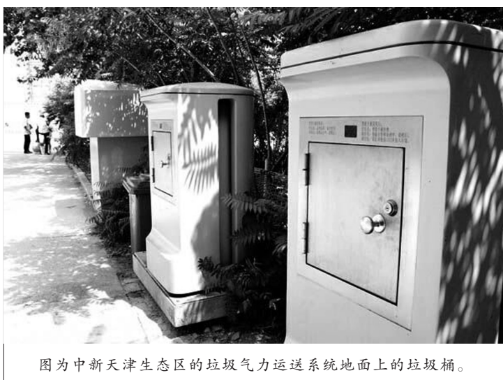
垃圾气力输送系统主要由垃圾桶、地下管道和中央收集站组成。其中,中央收集站的中控室是每一套系统的大脑,通过一个大屏幕就可以清楚地看到每一个垃圾回收箱的状态,而每一个垃圾回收箱就像是神经末梢一样,不停地回传即时信息。如果某个点位显示为橘红色,就说明垃圾桶已经装满,就可以操作系统进行垃圾回收。
