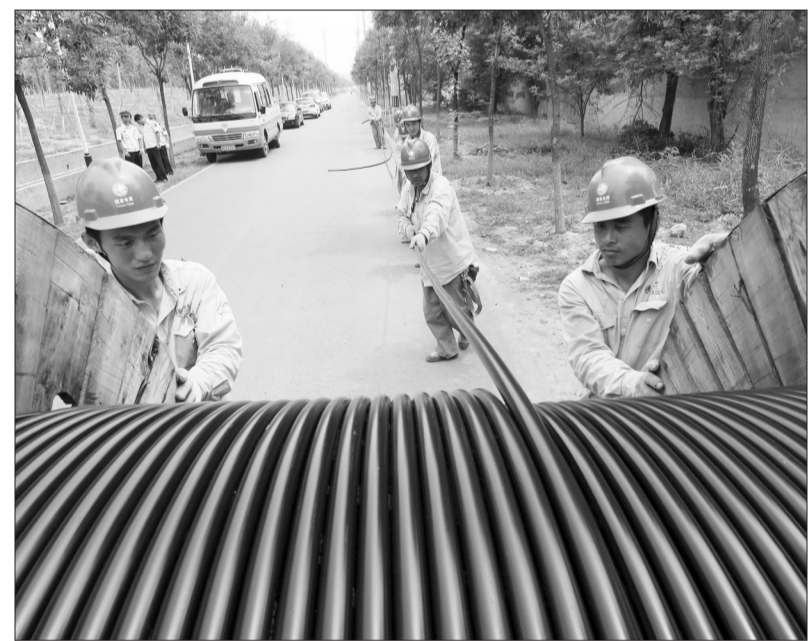
北京市朝阳区通过电厂关停、企业燃煤锅炉改造、居民散煤治理等措施压减燃煤。朝阳区共有153个村庄、社区约4.8万户需进行煤改电工程,可压减燃煤15万吨。图为朝阳区金盏乡梨各庄村煤改电施工现场,供电局员工正在进行电力扩容作业。 本报记者邓佳摄
