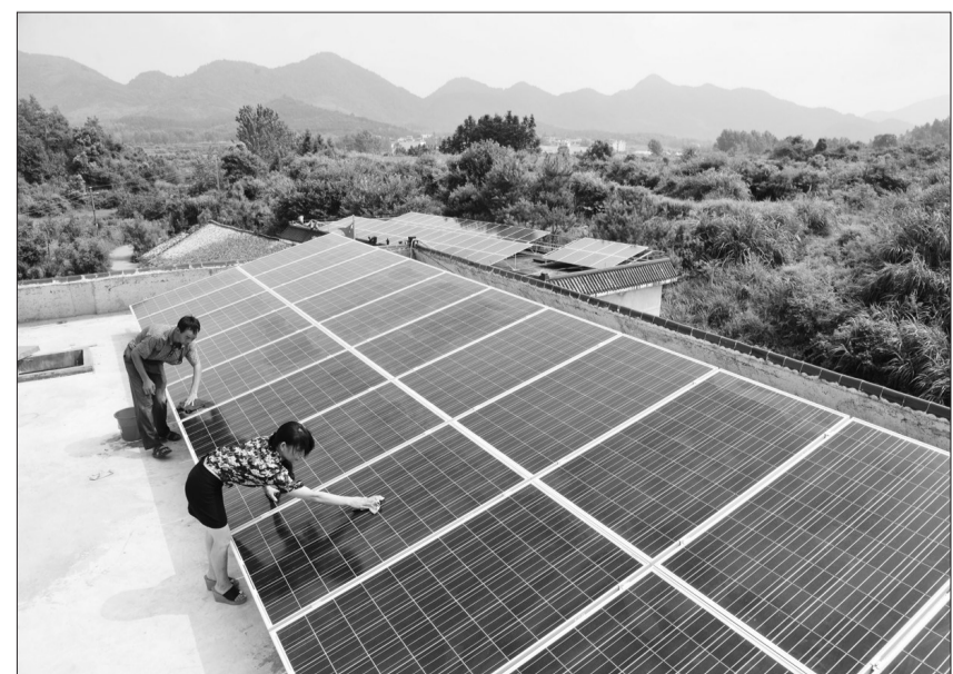
江西省新余市实施“光伏领跑 绿色崛起”战略,立足精准产业扶贫,以35个贫困村为主战场,整合光伏扶贫资金5590万元,在全省率先实施集中式光伏扶贫电站项目,帮助群众脱贫致富。图为新余市分宜县洞村乡省级贫困村——程家坊村两名村民在擦拭房顶上的光伏设备。 谢宜摄
