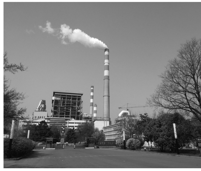
图为华电国际邹县电厂超低排放改造现场。
