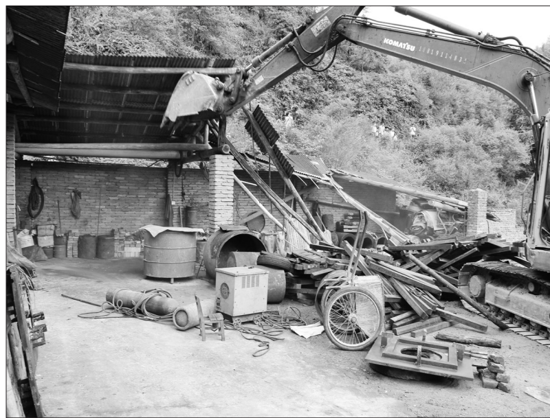
8月2日,江西省遂川县政府组织环保局、公安局、国土局、城市综合执法局等部门和县供电公司成立综合执法组,对辖区内一家严重影响周边环境且存在重大环境隐患的企业进行强制拆除。 郭烈明摄
