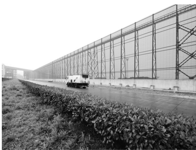
封闭式煤场防网防止煤尘逸散。
