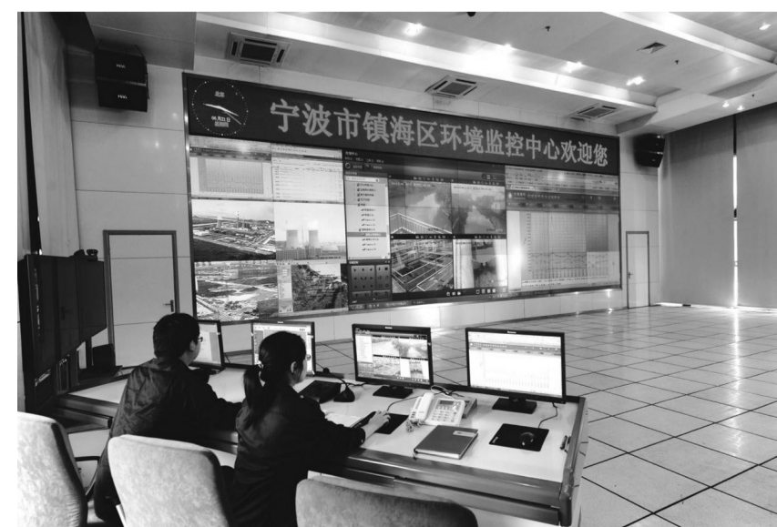
全国环保系统装备一流的镇海区环境监控中心。
