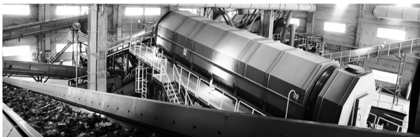
水泥窑协同处置城市生活垃圾示范生产线。
