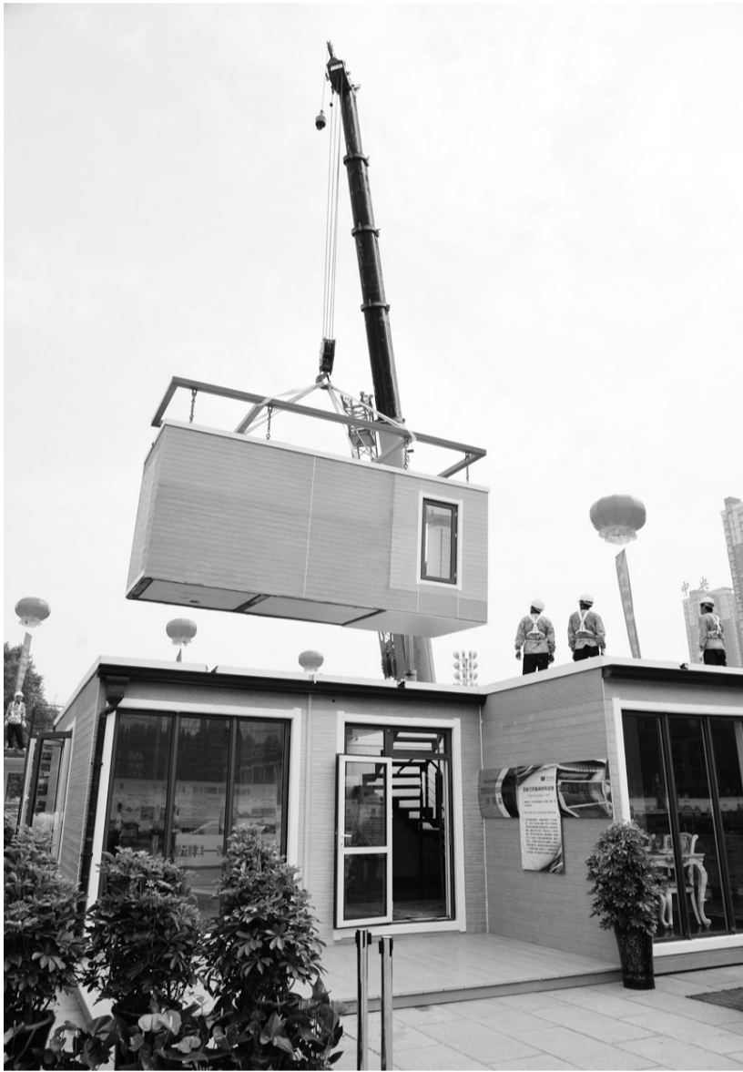
装配式建筑建造方法类似“搭积木”,可有效缩短施工时间,减少建设过程中的污染。
