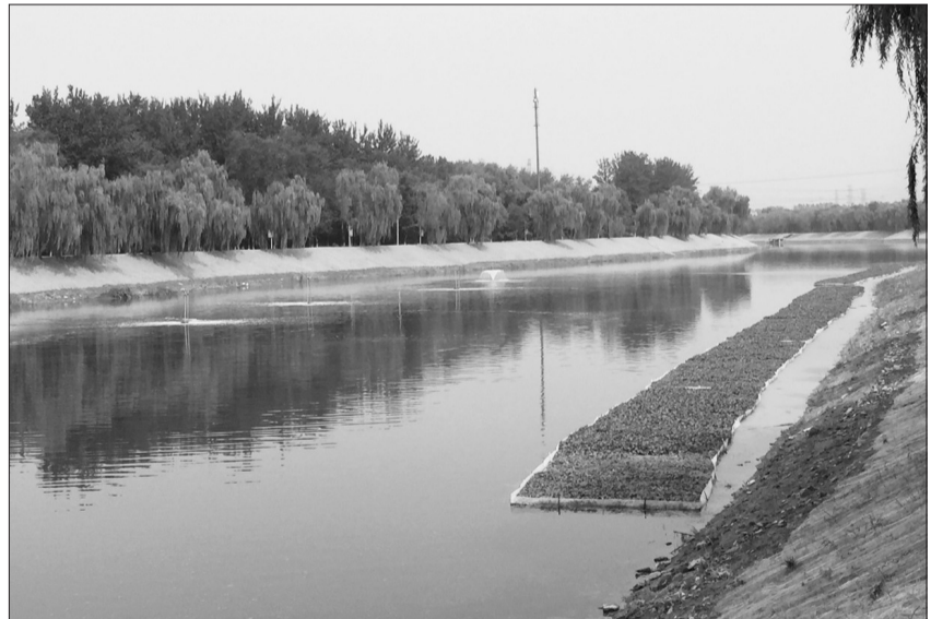
北京市南沙河具有防洪、排水、生态、旅游及景观等多种功能。在北京市公布的第一批黑臭水体治理名单中,南沙河3条河段的黑臭级别均为轻度黑臭,完成时限都是2017年12月。图为南沙河海淀段,经过河底清淤施工后,河岸建有人工浮岛和曝氧泵,帮助净化水质。
