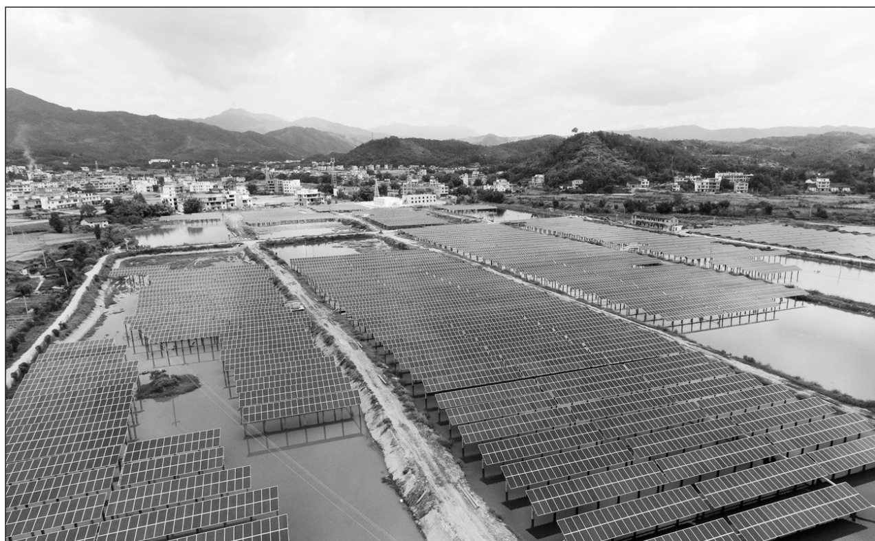
江西省上犹县管前镇的30MW“渔光互补”光伏发电项目近日成功投产。据了解,这种“渔光互补”新型光伏发电形式采取“上层光伏发电、下层水产养殖”的模式,有效节约了土地,具有生态、节能、性价比高等优点,实现了经济发展与生态建设共赢。 人民图片网供图
